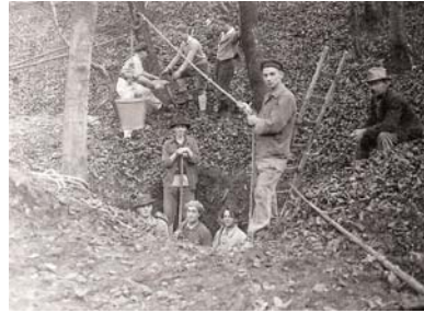
September 1931 beim graben
