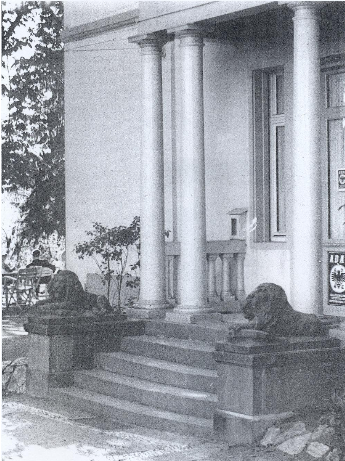
Landgut Mariahall, östlicher Eingang
