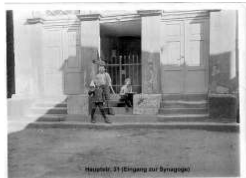
Hauptstr. 31 Eingang der Synagoge
